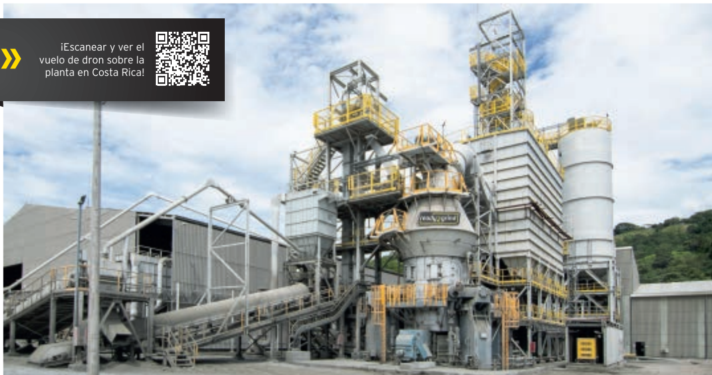
R2G 2500 C-4: Un molino MVR con cuatro rodillos molidores sigue siendo el elemento esencial de la planta ready2grind en Costa Rica.
