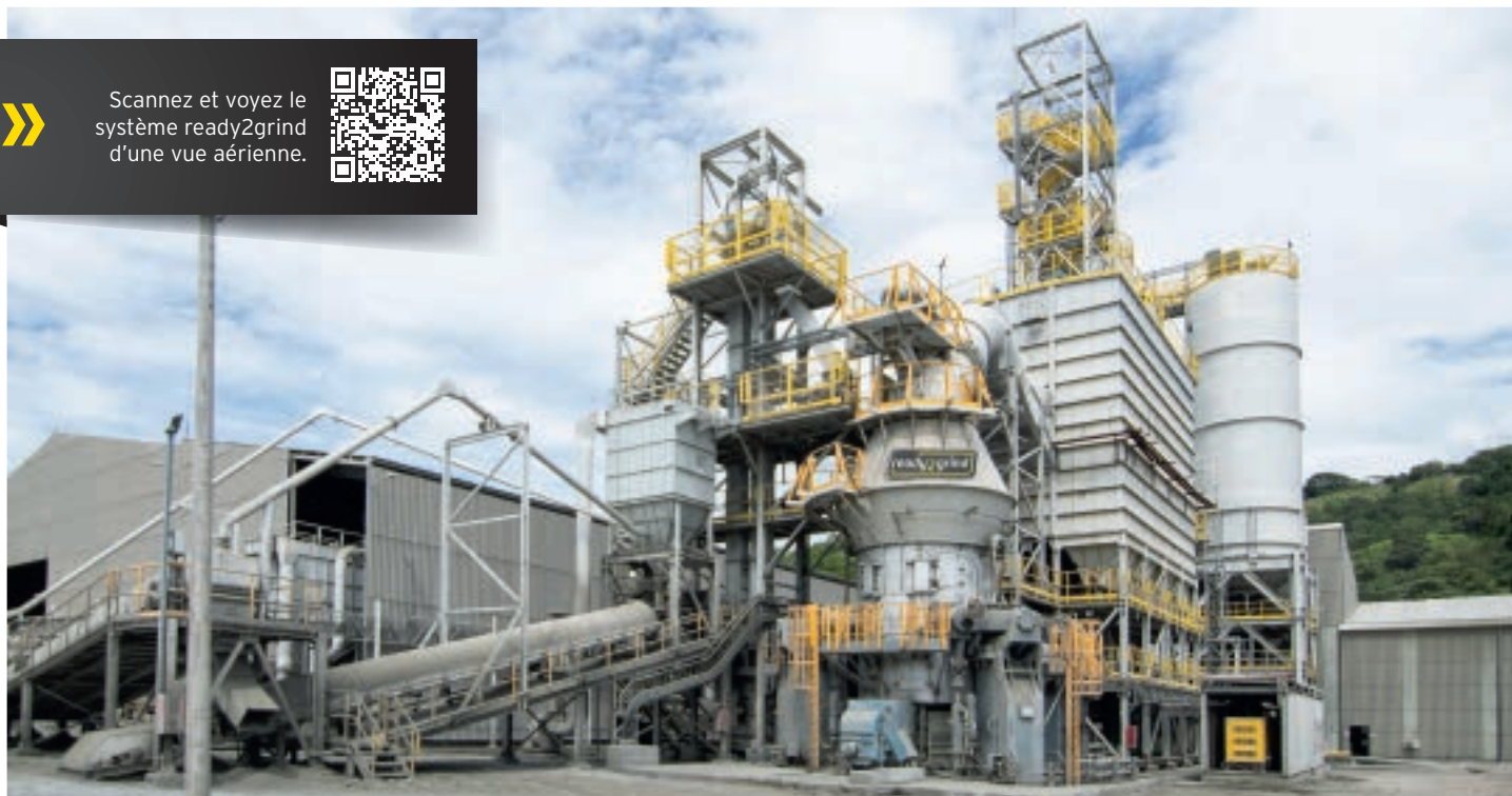
R2G 2500 C-4: Le cœur du système ready2grind au Costa Rica est, comme toujours, un broyeur MVR avec 4 galets de broyage.
