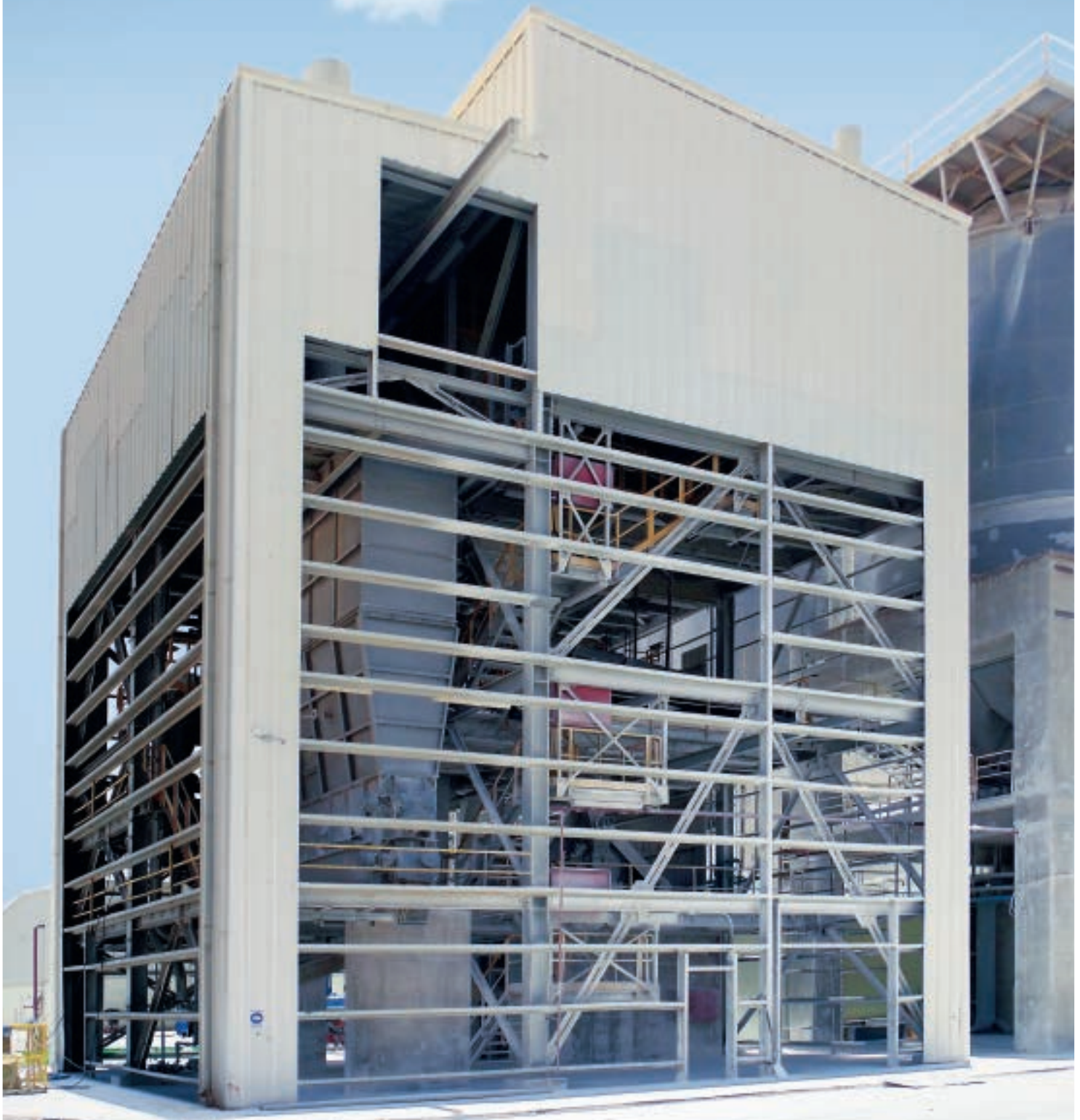
Kalklöschanlage in Saudi-Arabien inkl. Hochleistungssichter SLV, Kugelmühle MRD und Kalklöschmaschine KLV
